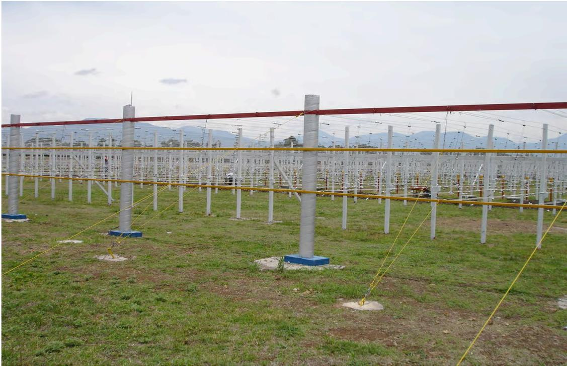
**La fotografía muestra una sección del arreglo dipolar del MEXART, El arreglo requiere una serie de mantenimientos que se dan a lo largo del año: limpieza de maleza, pintura, sustitución de elementos defectuosos, etc, El arreglo ocupa un área de 12,000 m<sup>2</sup>.**
