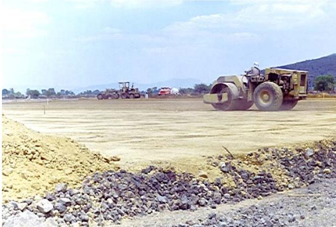
**Figura 13.** Levantamiento de la plataforma de la antena y limpieza del terreno
