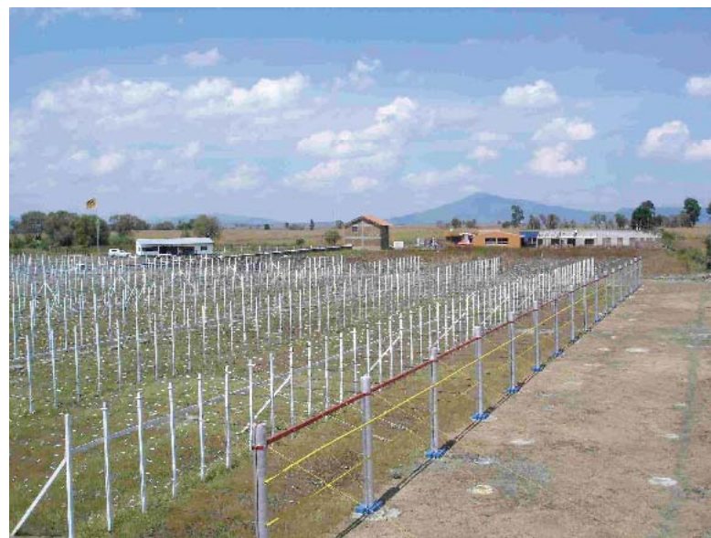
Vista de la antena del MEXART y parte de sus instalaciones
